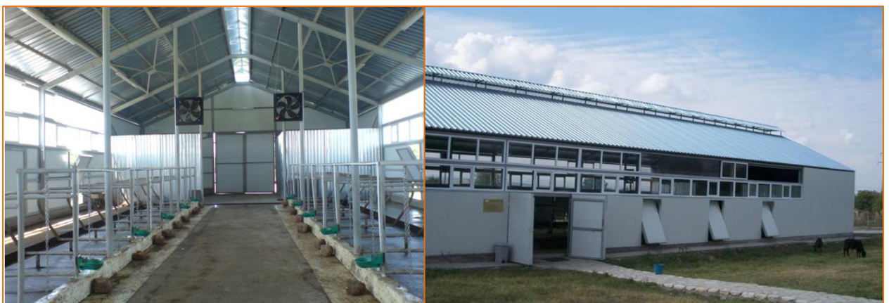
სურ. 12. სამროხე ჭერის მთელ სიგრძეზე ჰაერგამწოვი არხით, ასაშლელი მყარი გვერდითი კედლებითა და ვენტილიატორებით (გუჟანის მუნიციპალიტეტის დაბა კაჭრეთის საზოგადოებრივი კოლეჯი „აისი“)
