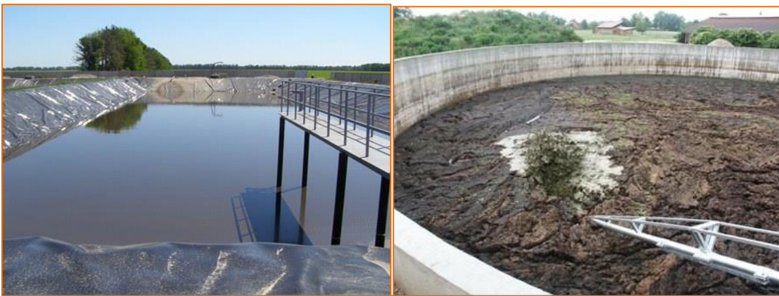
სურ. 32, 33. ფერმის ანარჩენების საცავის (ნაკელსაცავის) მოწყობის მაგალითი (ფერმის ტერიტორიაზე მისი განლაგების მოდელი იხ. სურ. 1-ზე)
