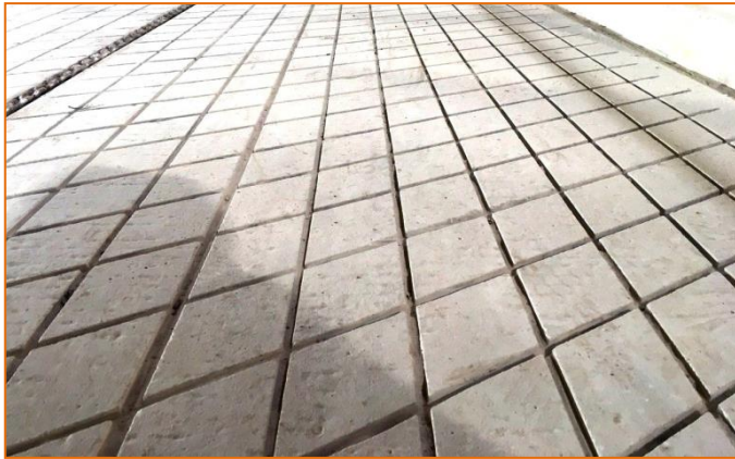
სურ. 26. სადგომში ბეტონის იატაკის დადარვის მაგალითი
